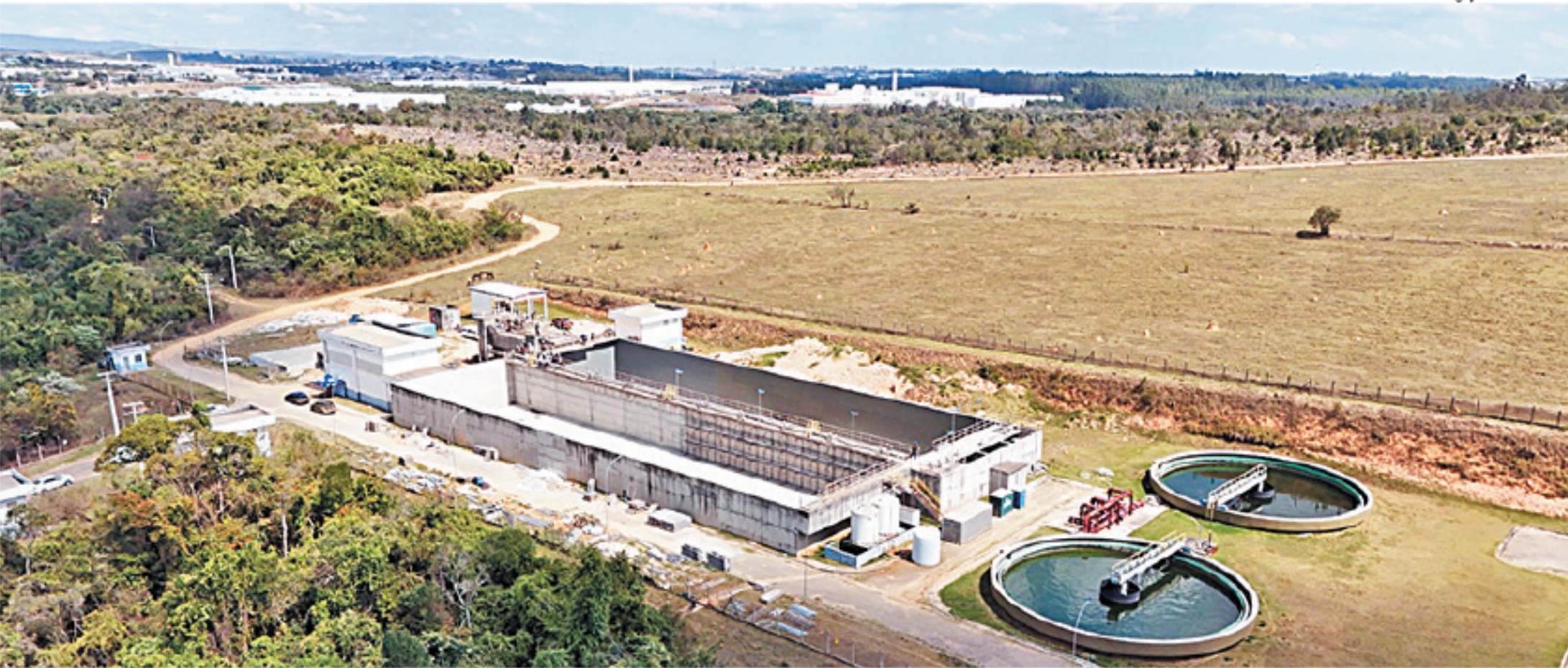
Estação de Tratamento de Esgoto Pirajibu, localizada na região do Pirapitingul, avança na modernização para dar conta de suprir a demanda com a vinda de empreendimentos ao município
